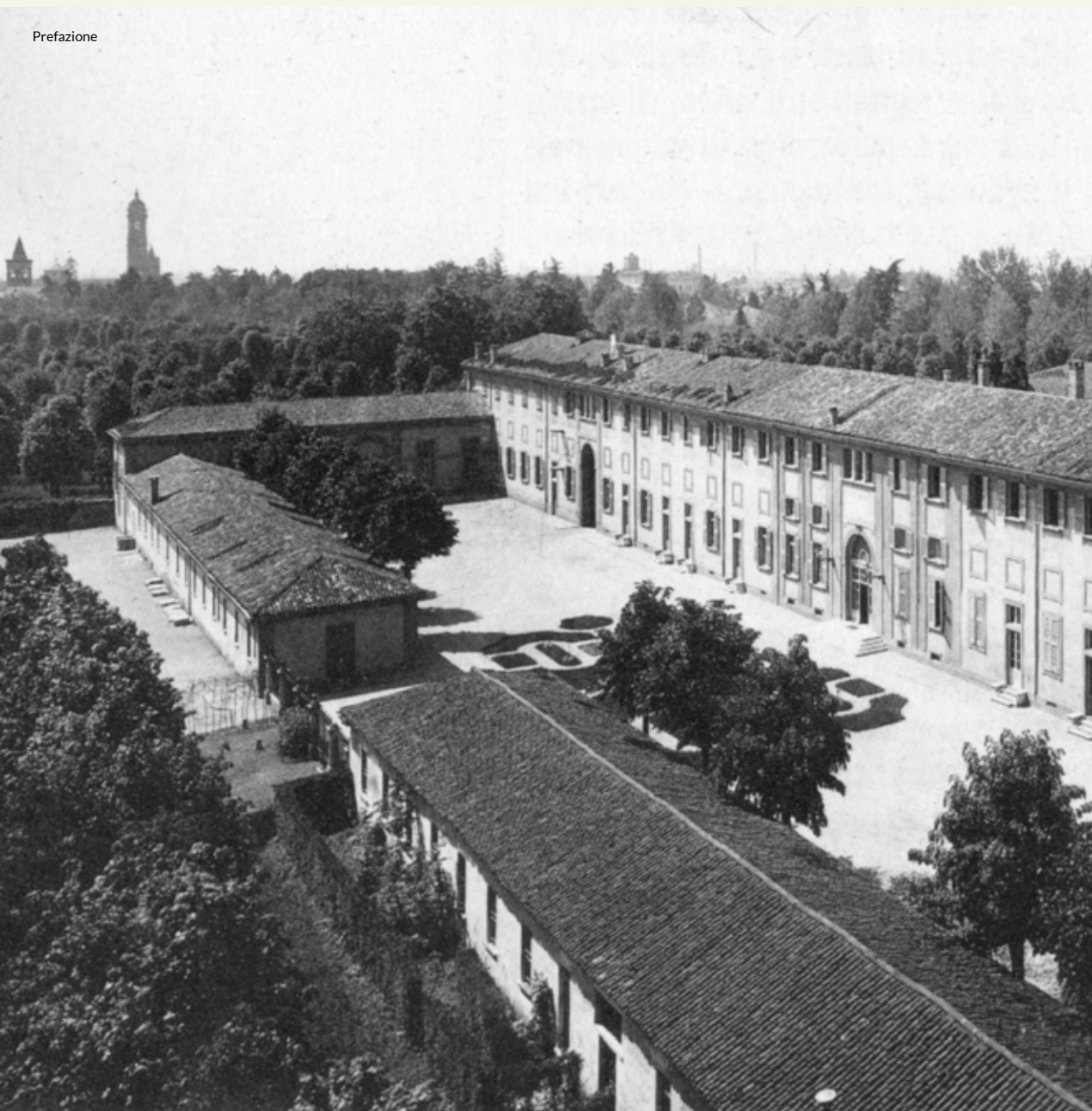
Le dipendenze meridionali della Villa Reale di Monza con il cortile dell'Università delle Arti decorative e i laboratori sulla sinistra. All'orizzonte la torre dell'Arengario e il campanile del Duomo. Sulla destra, oltre i Vivai Reali, il corpo ottocentesco di villa Esengrini (foto Rino Bianchi, Monza – courtesy Archivio Associazione Pro Monza).
